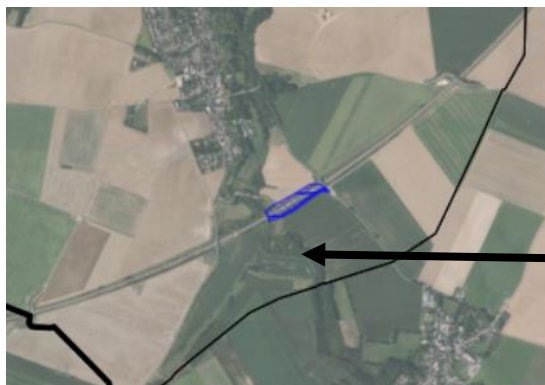
Talus de voie ferrée
